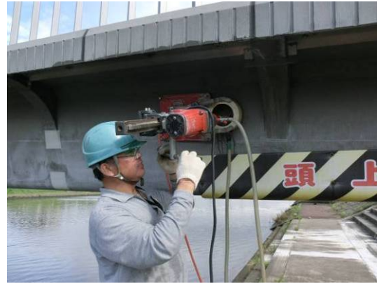
写真3 実橋ウェブからのコア抜き作業の状況
