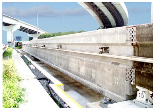
東京モノレール車庫線軌道桁
