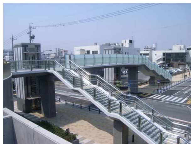
豊田市総合体育館横断歩道橋
