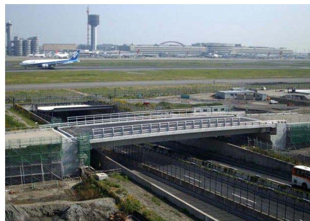
羽田空港GSE橋梁
