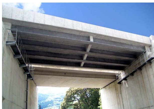
北九州JCT堀越Cランプ橋
