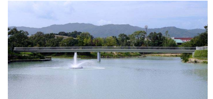
三兼池橋(福岡県) 桁高スパン比1/40を実現
