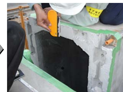
ドライジョイント接着剤塗布
