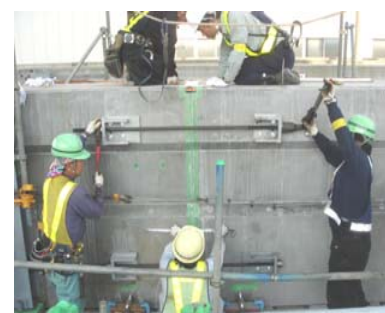
ドライジョイント桁引寄せ
