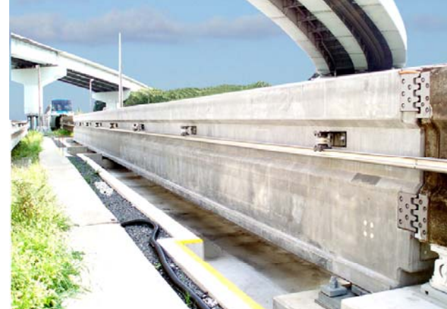
車庫線 40m軌道桁
