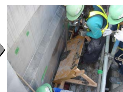
ウエットジョイント打設
