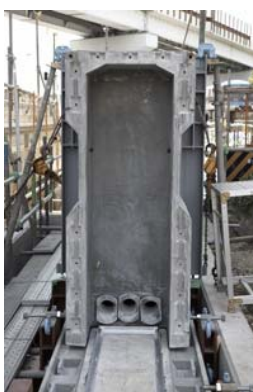
車庫線 40m桁断面
