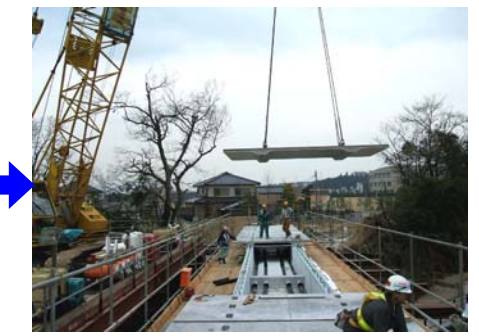
床版設置状況
