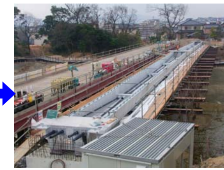
主桁設置完了・PC鋼線挿入
