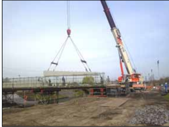
セグメント架設工
