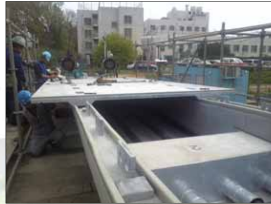
床版ブロック設置工
