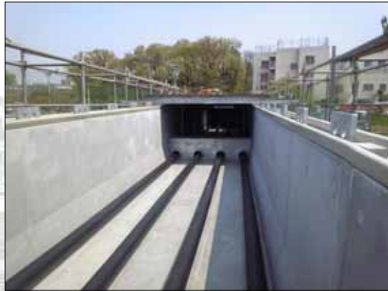
外ケーブル設置工
