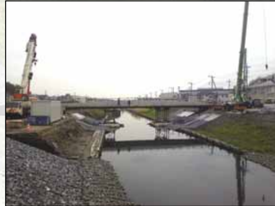
セグメント架設工全景
