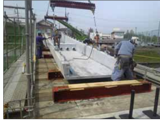
セグメント架設工
